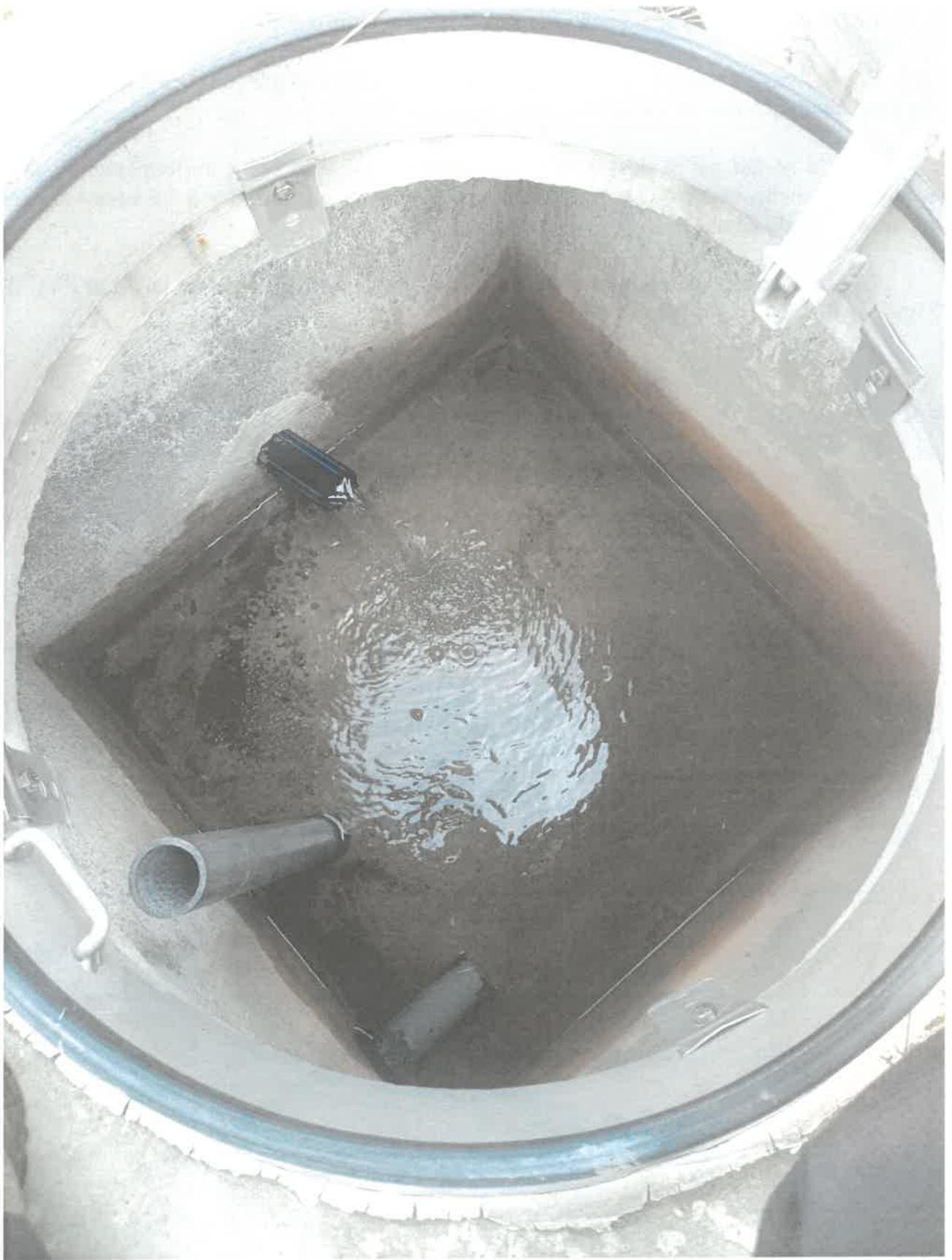
Une conduite d'adduction en PEHD de 63 mm de diamètre relie les captages entre eux vers le collecteur-décanteur aval, elle est munie d'une crépine au départ des deux ouvrages.
